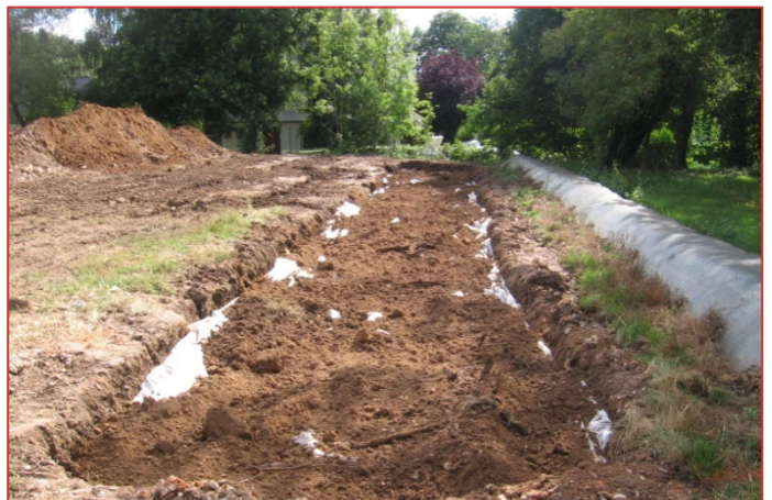
Mise en place du géotextile et de la terre végétale
