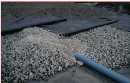
Géotextile supérieur sur le massif
