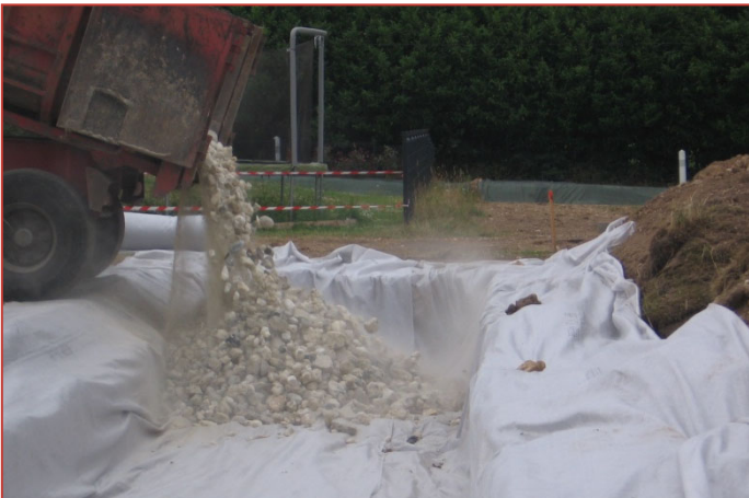
Mise en place de la grave
