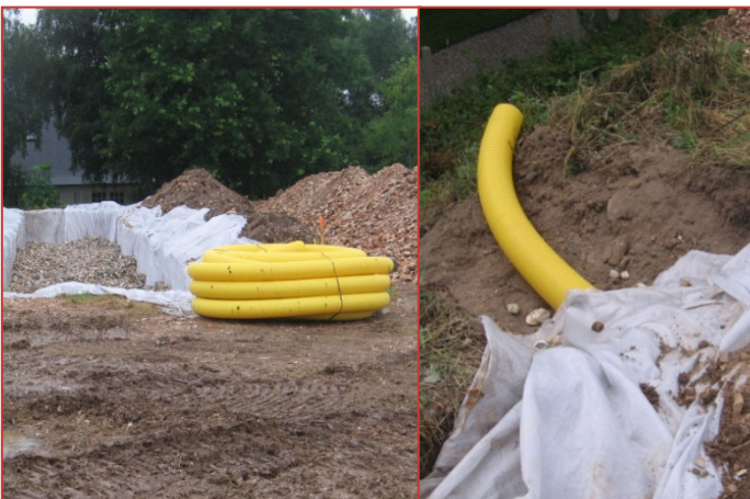
Installation de la canallisation de drainage
