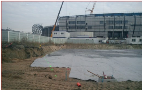
Mise en place du géotextile
