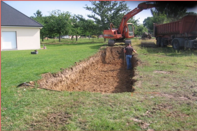
Terrassement du massif drainant
