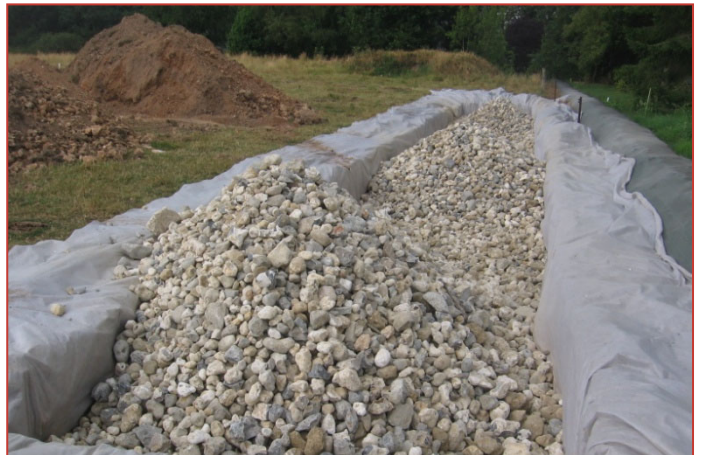
Mise en place du géotextille
