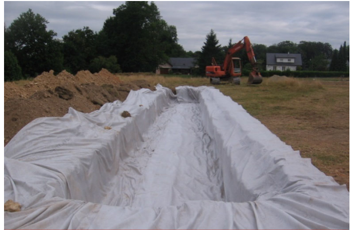
Mise en place du géotextille
