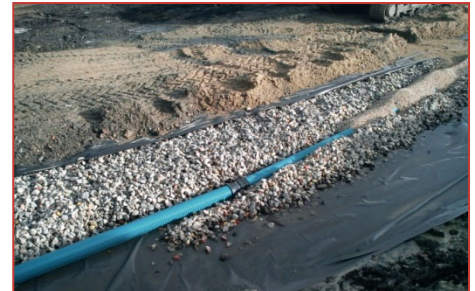
Mise en place du massif drainant
